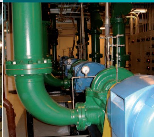
Qu'il s'agisse de l'approvisionnement en eau surchauffée à partir de centrales de chauffe, d'eau glacée pour les systèmes de climatisation ou de fluides thermiques dans les process de l'industrie chimique – la réalisation de bilans énergétiques devient indispensable suite à la hausse constante des coûts. La version « Energy » de **FLUXUS® F601** permet une analyse simple et rapide des flux thermiques d'une installation.
